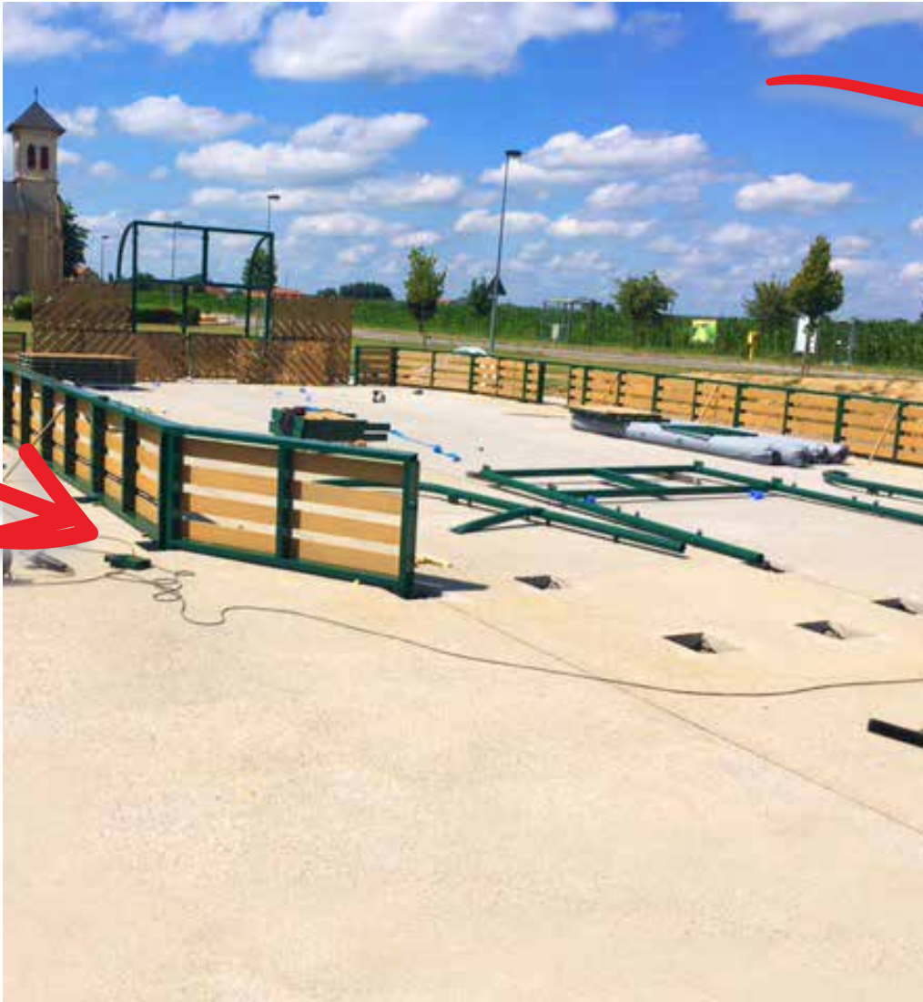
Etape 3 : Fourniture et pose de CITY STADE®
