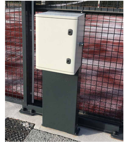
Armoire sur pied avec disjoncteurs , horloge micromat et contacteur à clé.
